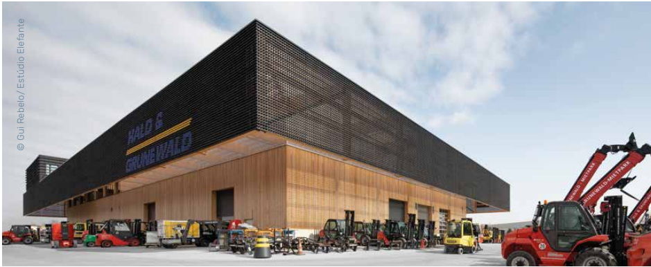
Firmensitz, Rottenburg, Baujahr: 2022
