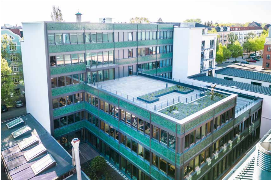
Holz-hybrides Bürogebäude, Hamburg, Baujahr: 2022
